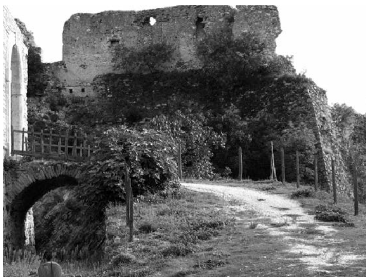
Figura 3. Laviano. Il castello. Particolare del ponte levatoio
