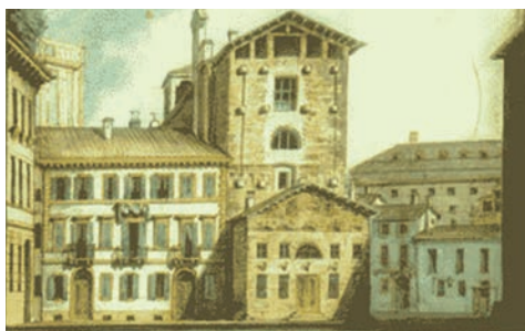
Milano, il cantiere del Teatro dei Filodrammatici, 1798
